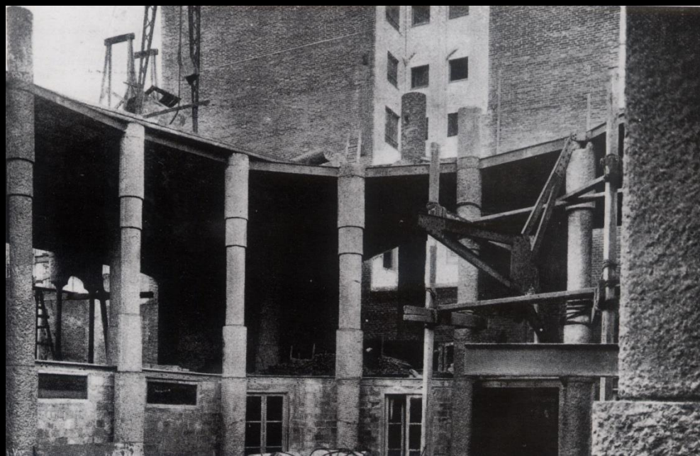
Combinació de pillars d'obra, pedra i bigues de ferro a la planta baixa i a l'entresòl. S'hi observa la senzilla solució de tondors i cabirons de fusta per al muntatge de l'estructura.
