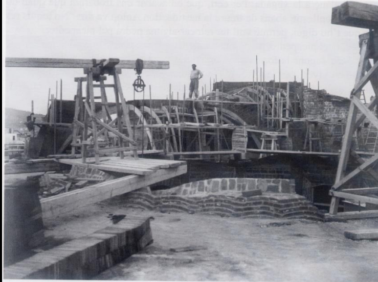
Les golfes de la Pedrera en obres. S'hi poden observar els xindris per a la construcció dels arcs d'un sol full de maó i els llistons verticals que senyalen les alçades. És remarcable el capçat dels murs del pati en forma d'ondulació, que constitueix un seguit d'arcs de descàrrega.
