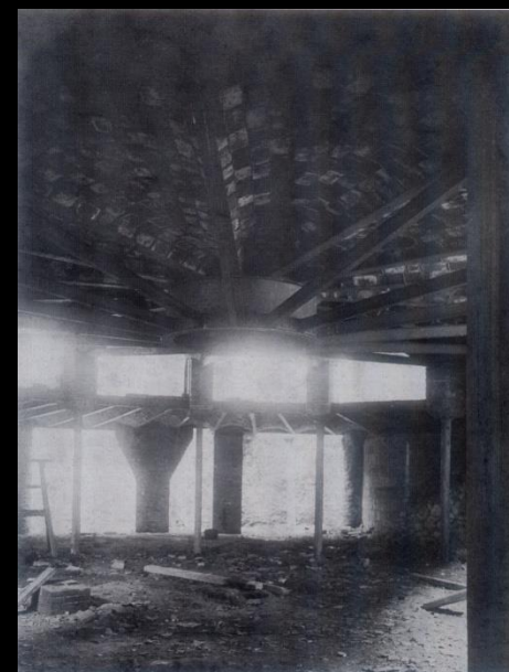
Estructura de pillars de fosa i bigues laminades a la sala circular del soterrani.
