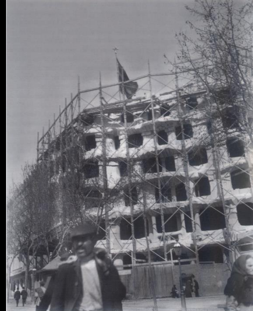
La façana de la Pedrera amb la bandera de la coberta d'aigües. S'hi observa la simplicitat de la bastida i la bastantesa de les pedres que calgué retocar posteriorment.
